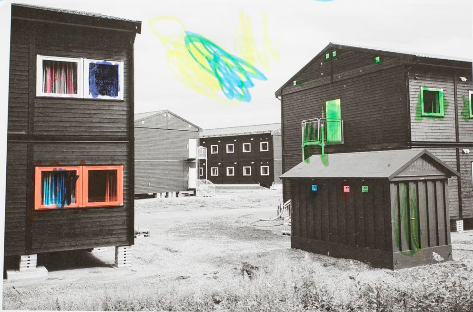
"Entreprenörsboenden" i svart som färdigställs av Stegra på Slipvägen 1 i Boden, 4 augusti 2024.
